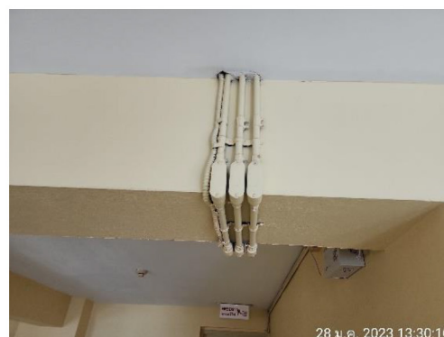
ภาพที่ 2-11 การเดินสายไฟฟ้า สายสัญญาณต่างๆ อย่างเรียบร้อย
