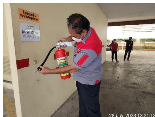
ภาพที่ 2-5 เจ้าหน้าที่ตรวจสอบถังดับเพลิงเคมี
