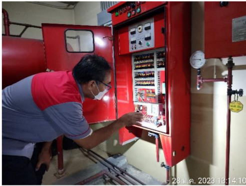
ภาพที่ 2-6 การทดสอบการทำงานของเครื่อง สูบน้ำดับเพลิง
